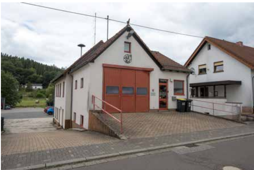
Feuerwehrgerätehaus in der Sitzerather Straße
