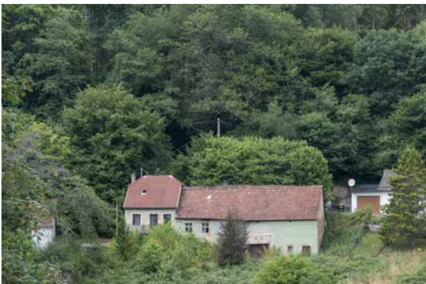
Beispiel: sehr stark sanierungsbedürftiges Gebäude im Cloefweg
