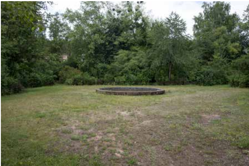
Stillgelegte Brunnenanlage im nördlichen Bereich der Parkanlage
