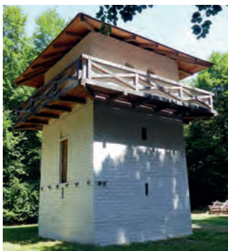
Limes-Wachturm in Limeshain: Der mit antiken Bautechniken und authentischen Baustoffen rekonstruierte römische Wachturm 3
