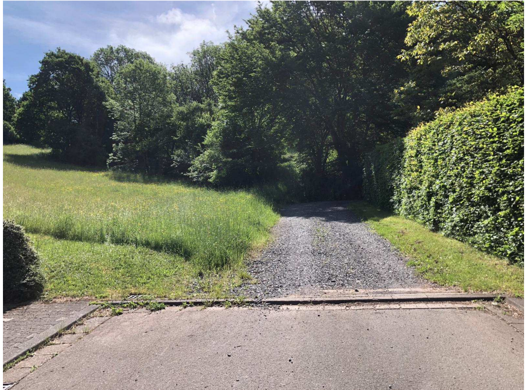
Abb. 03 – Ende Stickerschließung „Hinterm Krähenbusch“, hier geschotterter Feldweg, Bestandsaufnahme vom 22.05.2022; Quelle: Vermessungs- und Ing.-büro M. König,
