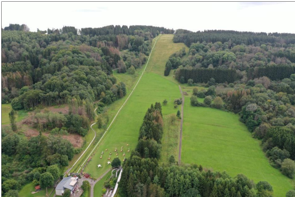
Foto 23: betroffene Wiesenbereiche am Unter- und Mittelhang des Peterberges
